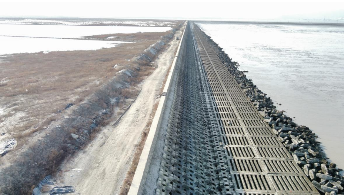
海堤护坡现状图
